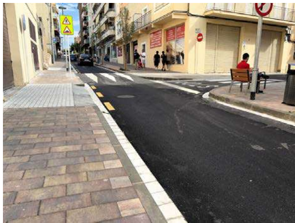
Imatge de com ha quedat el carrer dels Filadors després de les obres. / AJ. TORREDEMBARRA
