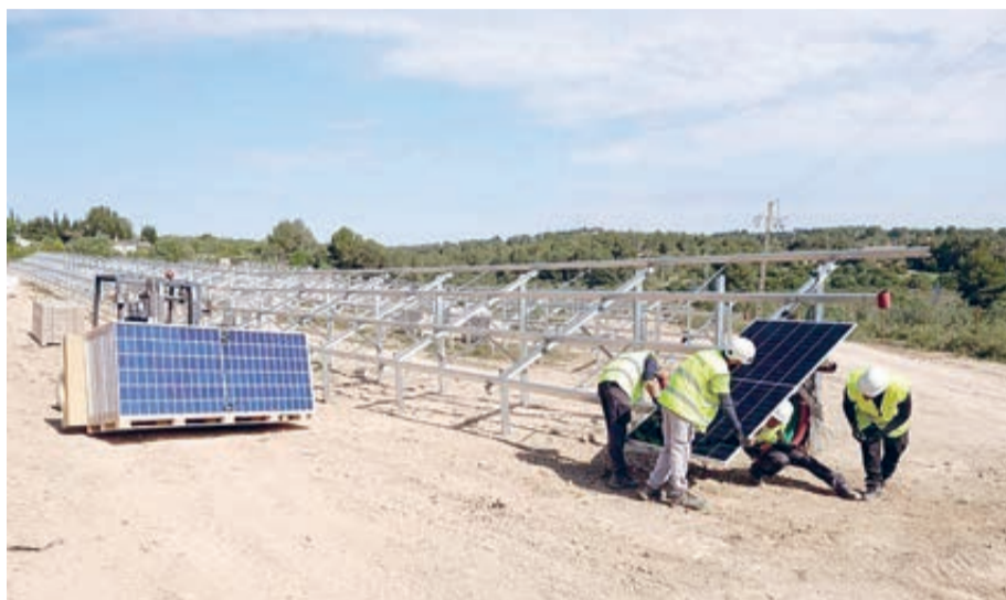
Instal·lació de les primeres plaques al parc solar del Catllar. / CEDIDA
