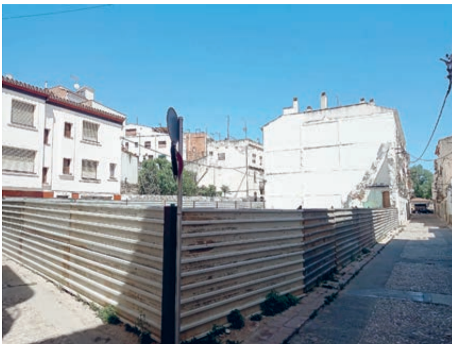
L'espai on s'ubicarà l'edifici destinat a llar residencial projectat per l'Onada. / TDB
