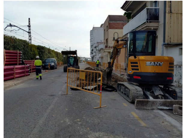
Una imatge de les obres a Baix a Mar. / AJ. TORREDEMBARRA
