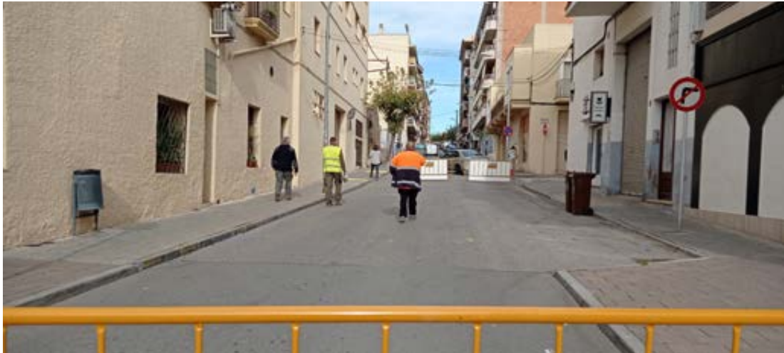
Les obres al carrer dels Filadors ja s'han iniciat. / TDB
