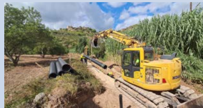
Una imatge dels treballs per construir la depuradora. / AGBAR
