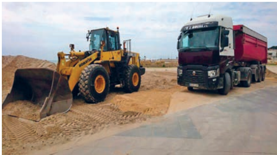
Màquines treballant a la platja de la Paella de Torredembarra l'any passat. / TDB
