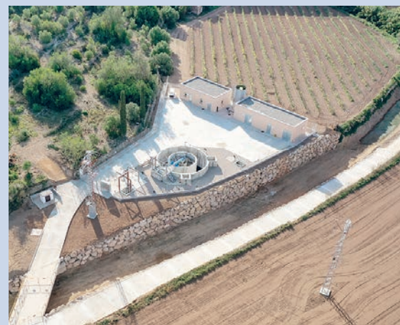
Una imatge aèria de la nova depuradora de la Nou de Gaià. / GOVERN DE CATALUNYA
