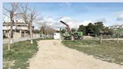
Una imatge de les obres que acaben de començar per ampliar els equipaments esportius de Creixell. / AJ. CREIXELL
