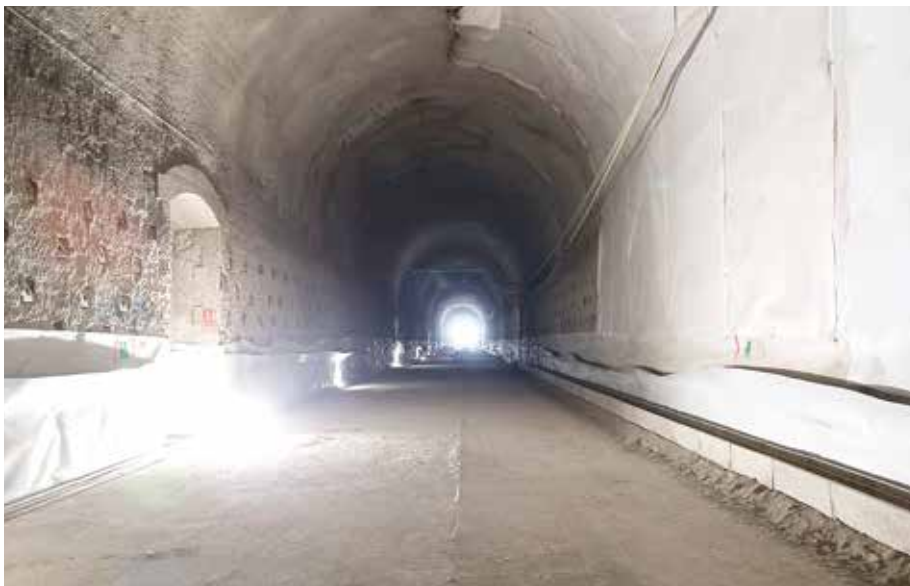
Les obres al túnel ferroviari de Roda de Berà avancen a bon ritme. / ADIF
