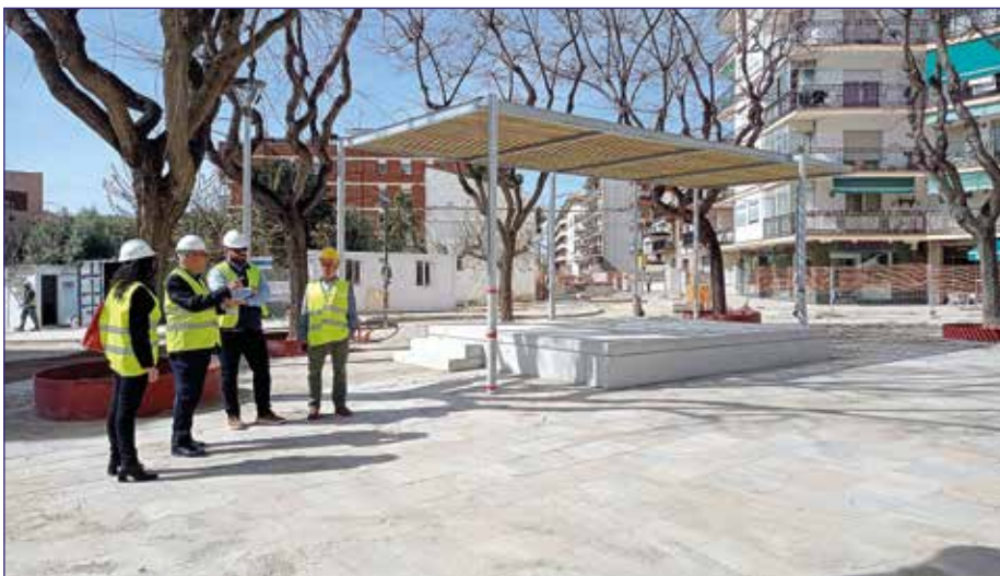
Una imatge de la visita d'obres. / TDB
