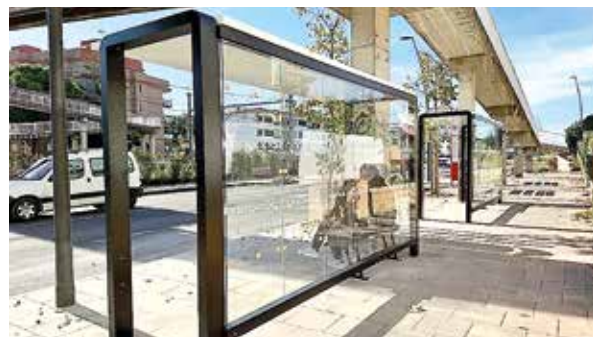
Una de les marquesines instal·lades al passeig Miramar. / ANNA F. / AJ. TORREDEMBARRA
