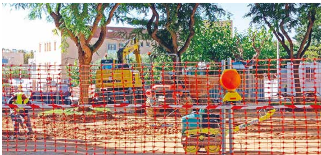
Una imatge de la primera fase de les obres a la plaça Catalunya. / TDB
