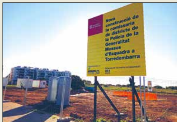
Primers treballs per a la construcció de la nova comissaria dels Mossos d'Esquadra a Torredembarra. / TDB
