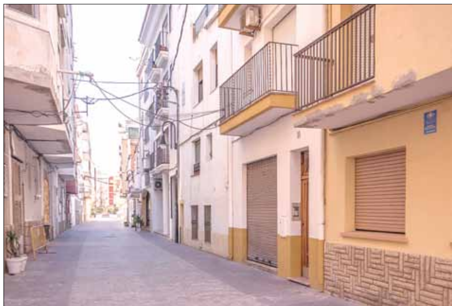
Una de les terrasses del carrer Isaac Peral afectada pels desperfectes causats pel pas de camions. / JOAN CASAS
