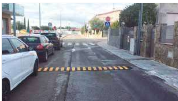
Foto: Banda reductora instal·lada al carrer Rosella. / TDB
