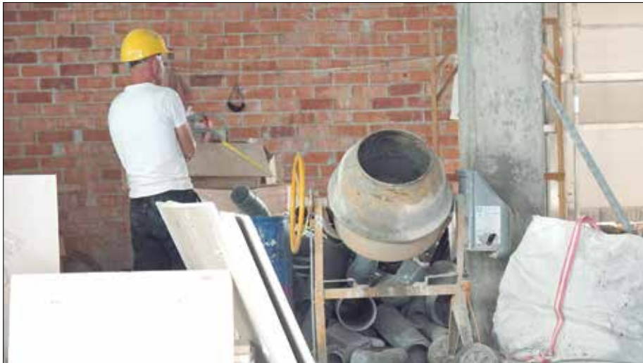
Des de 2017 ha tornat a haver-hi activitat en obra nova a Torredembarra. /CAROL CUBOTA
