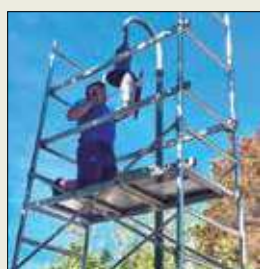
Una imatge dels treballs a la urbanització torrenca. / AJ. RODA DE BERÀ
